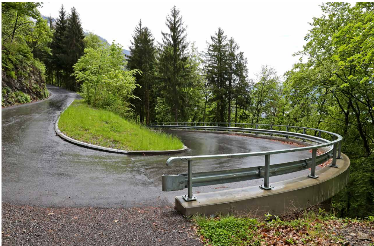
Fin des travaux relatifs à la réfection de la route de Valleyres.
