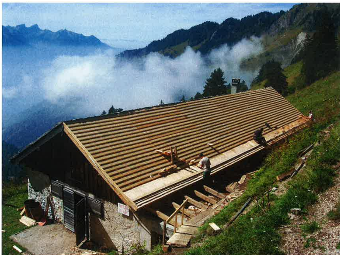
2012 Chalet d'alpage de Rafevex travaux de tavillonnage par l'équipe des forêts
